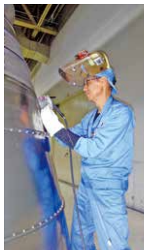
液体ロケットエンジン ノズルスカートの溶接作業
