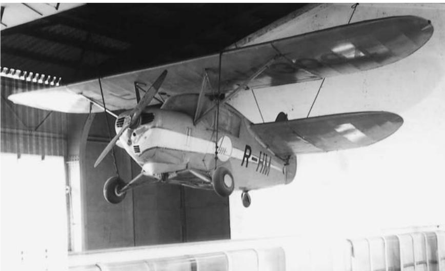
戦前から空の風（Pou-du-Ciel）として知られたフランスのHenri Mignet氏の設計になる特異な串型翼配置の軽飛行機を、戦後再設計したモデル。昭和29年春から同氏の指導のもとに新立川飛行機で製作が開始され、同年10月20日、Mignet氏自身の手により初飛行し
