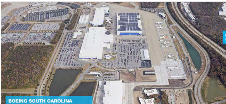
サウスカロライナ工場の全景（同社ホームページより）
